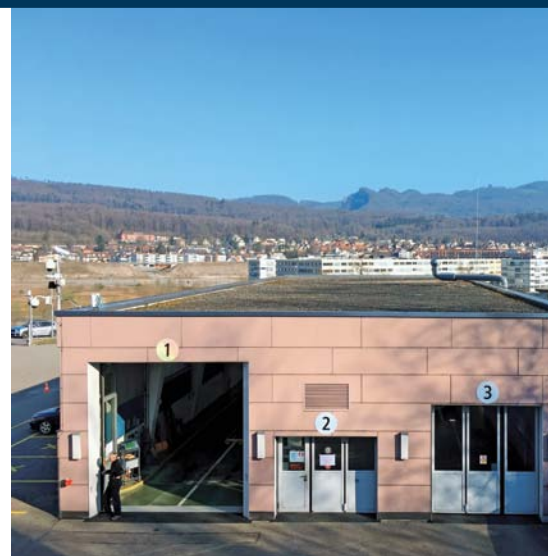
Die zu kleine Prüfhalle in Olten mit der neuen Wohnüberbauung im Hintergrund.
